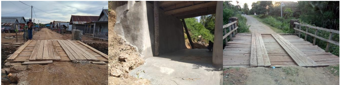
Gambar 3.5 Kegiatan pemeliharaan dan rehabilitasi jembatan
