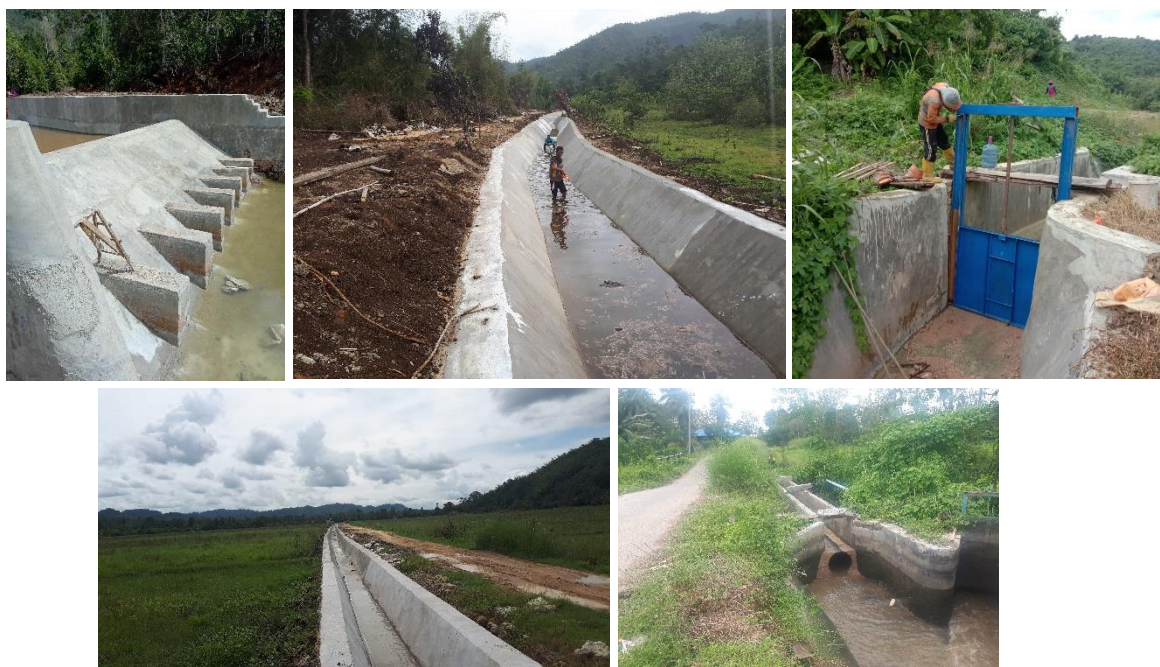
Gambar 3.3 Kegiatan pembangunan jaringan irigasi permukaan pada tahun 2021
