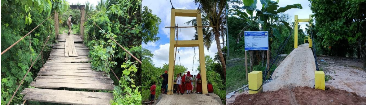
Gambar 3.4 Kegiatan penggantian jembatan gantung
