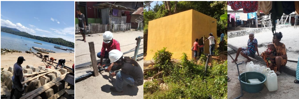
Gambar 3.2 Kegiatan pembangunan SPAM Jaringan Perpipaan di Kepulauan Masaloka Raya
