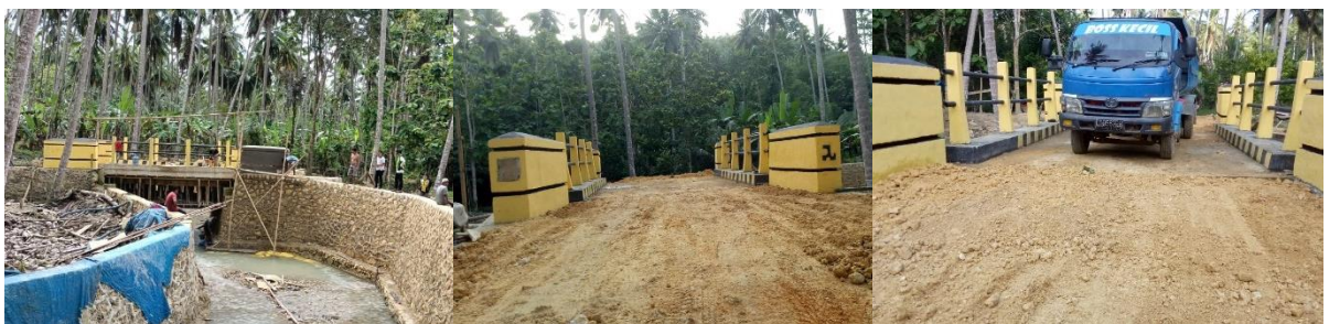
Gambar 3.3 Kegiatan pembangunan jembatan di Kelurahan Kastarib
