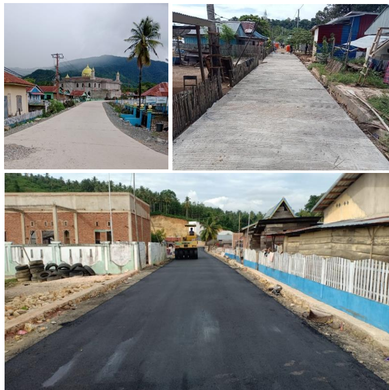
Gambar 3.1 Kegiatan rekonstruksi jalan kabupaten dengan aspal dan rigid beton
