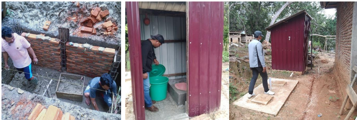
Gambar 3.9 Kegiatan pembangunan SPAD-S individual yang di Desa Morengke, Desa Lakomea, dan Desa Tembe
